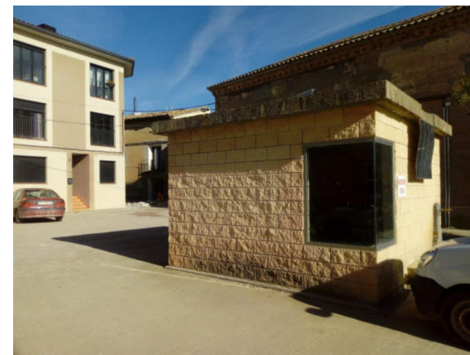
Captación de Chimillas
