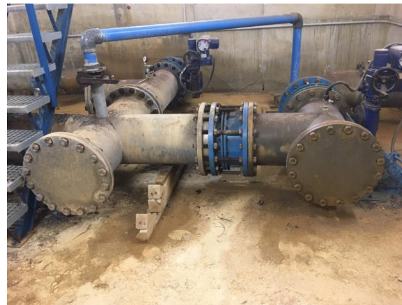
La foto muestra dos salidas de agua para futuras conexiones
