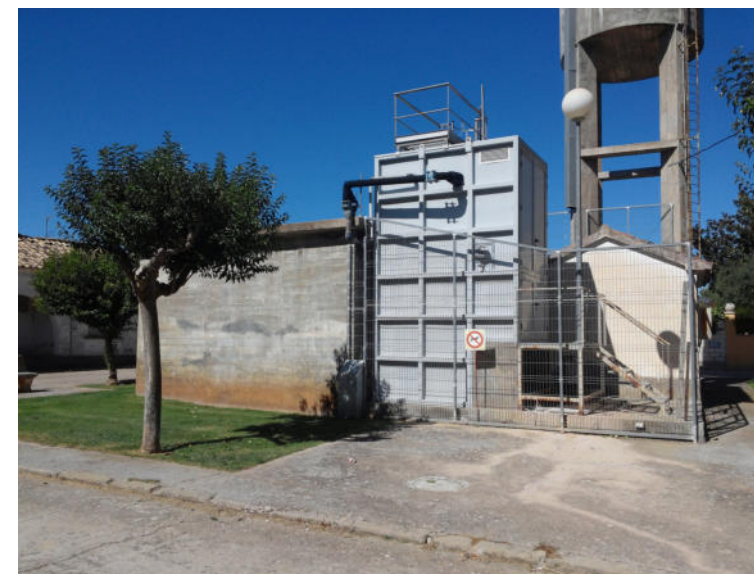
Depósito y ETAP de Banastás
