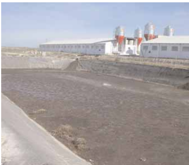
Foto 7: Balsa de almacenamiento de purín porcino.
